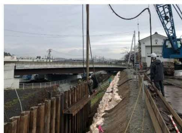
ため池・河川堤防での施工
