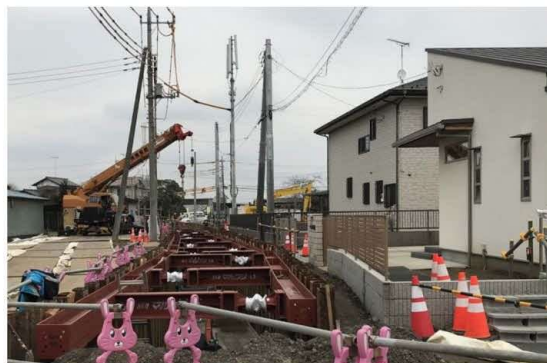
構造物際での施工
